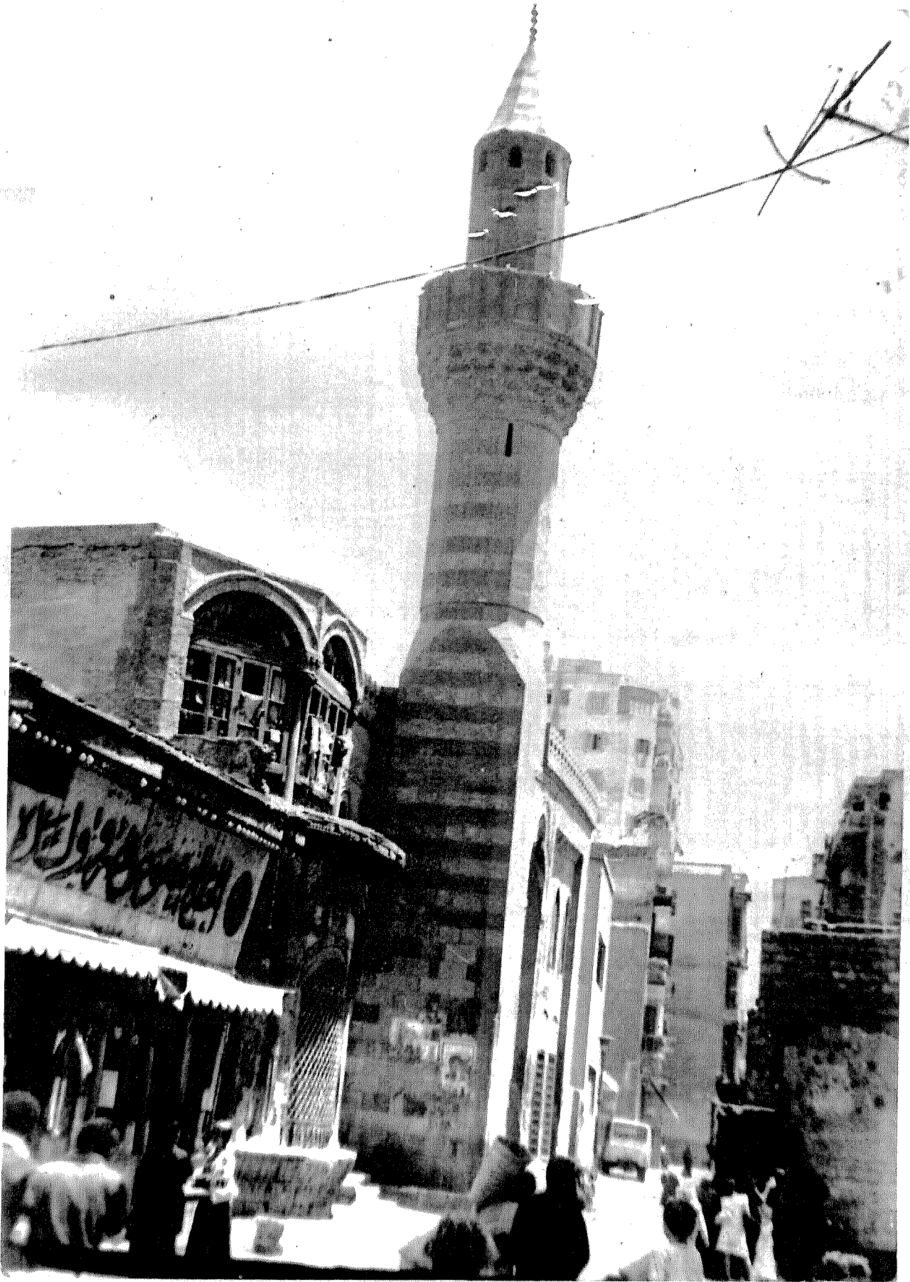
▲ لوحة (١١٨) الواجهة الرئيسية التي تشغل الضلع الجنوبي الغربي لمدرسة جنيلاط
